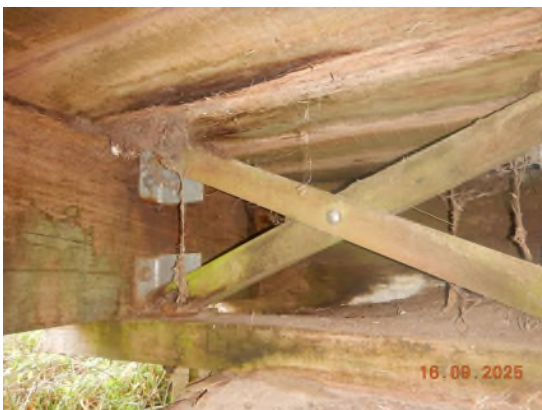
BEFESTIGUNG DER AUSSTEIFUNG
