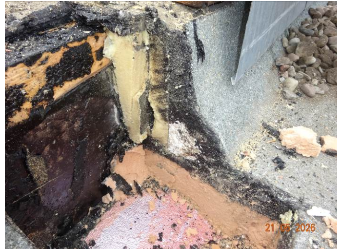
(38) Dachaufbau und seitliche Attikaabdichtung
