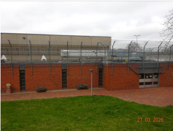
(20) Absicherungszaun – Umkleidetrakt (bleibt)
