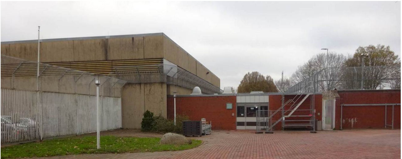
(3) Südansicht Sporthalle (Haus 2.6) – Links Sporthalle (OK Attika ca. +9,40 m) / Rechts Umkleidetrakt (OK Attika ca. +3,54 m)
