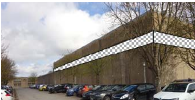
(9) Außenansicht – Lüftungsband (idealisiert)
