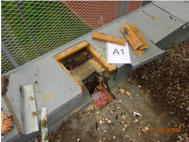
(37) Bauteilöffnung A-1 (Attika)
