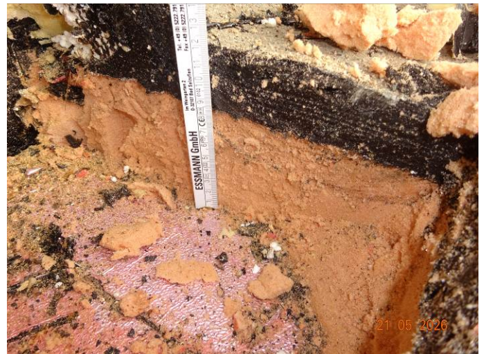
(44) Dämmung 8 cm, Abdichtung 4 cm
