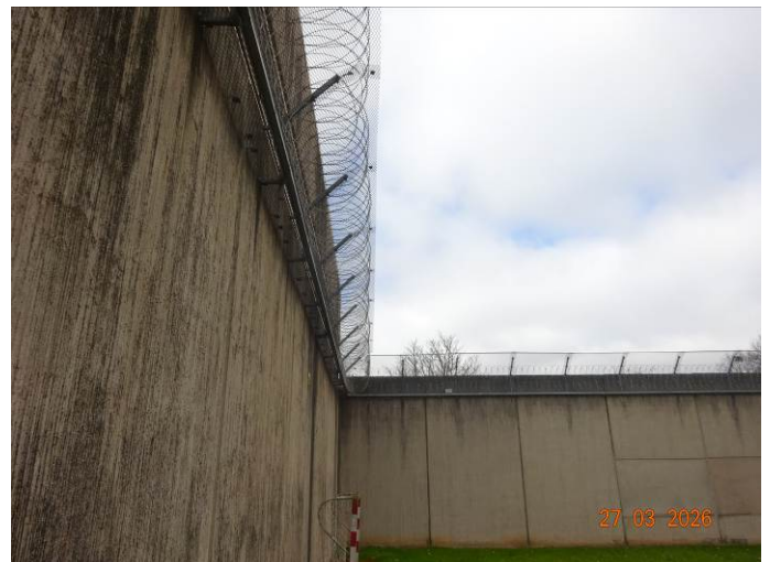
(25) Absicherungszaun mit S-Draht, ca. 1,3 m vorstehend
