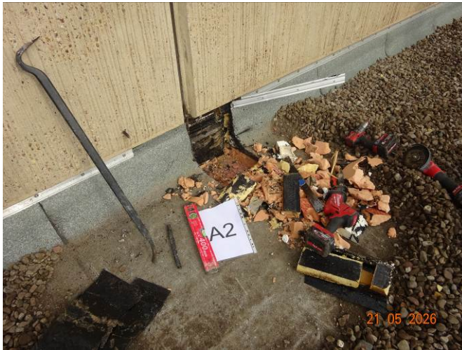
(41) Bauteilöffnung A-2 (Wand)
