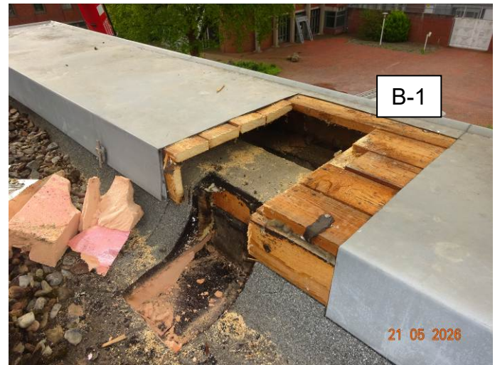
(46) Dachaufbau und seitliche Attikaabdichtung
