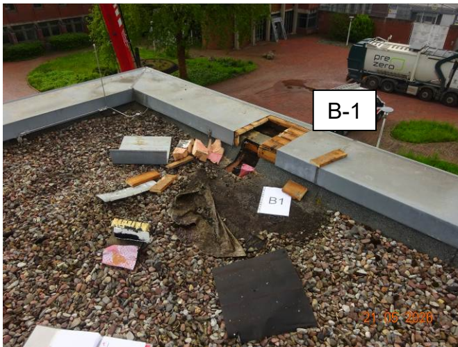
(45) Bauteilöffnung B-1 (Attika)
