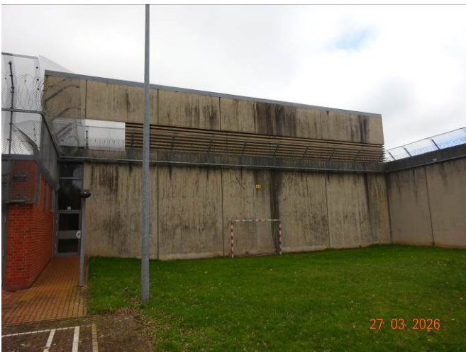
(24) Nordseite der Sporthalle – freistehende Gerüste erforderlich mit Schotterfläche
