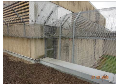
(18) Haupthalle, Nord / Ost
