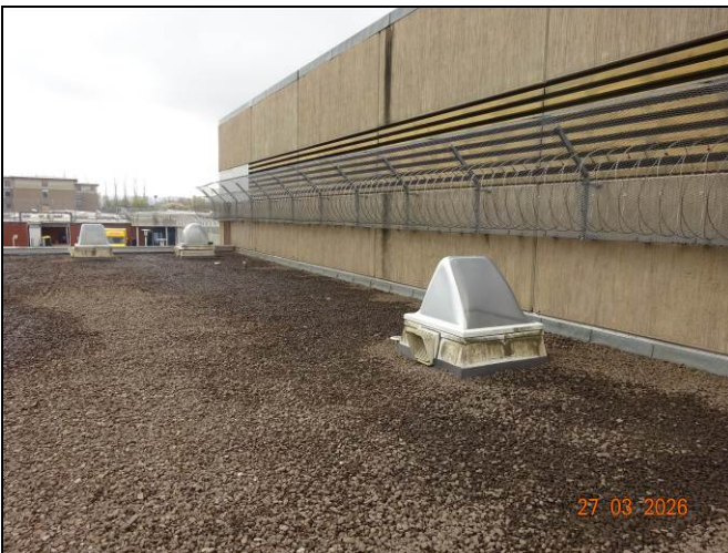
(22) Absicherung, Sporthalle Ost (wird demontiert)
