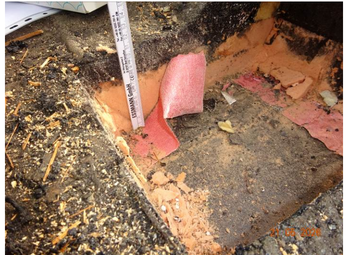
(50) Dämmung 8 cm, Abdichtung 3 - 4 cm
