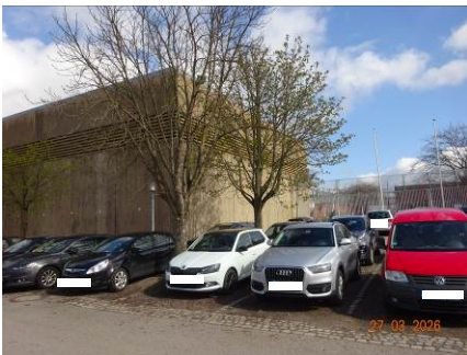
(16) Haupthalle, Süd / West
