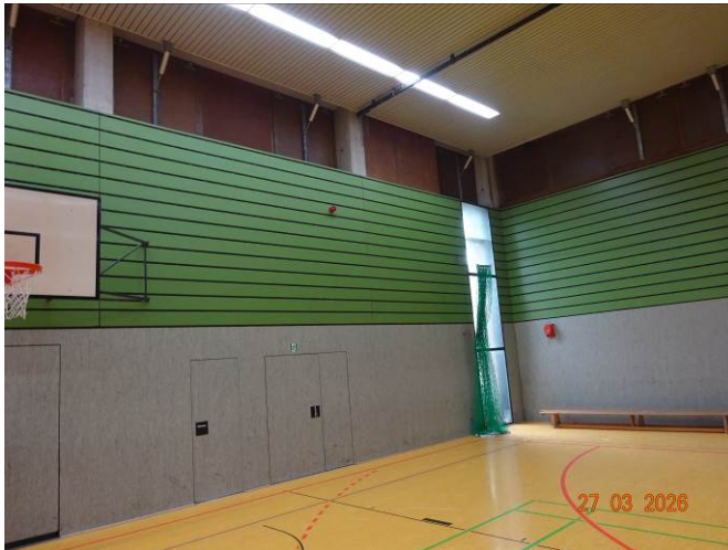
(7) Lüftungsklappen
