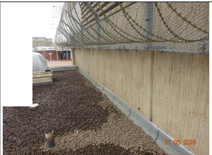
(23) S-Draht-Rollen in Kopfhöhe
