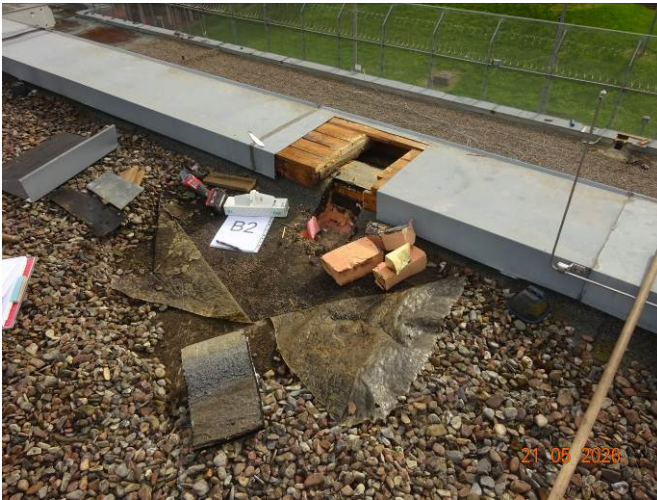
(49) Bauteilöffnung B-2 (Attika)
