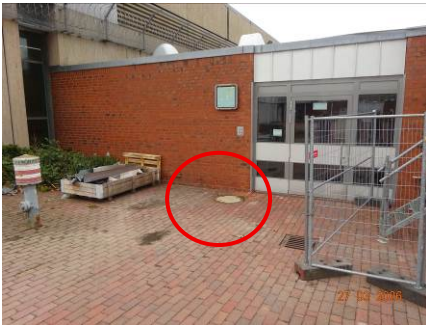
(29) Schachtdeckel vor dem Eingang
