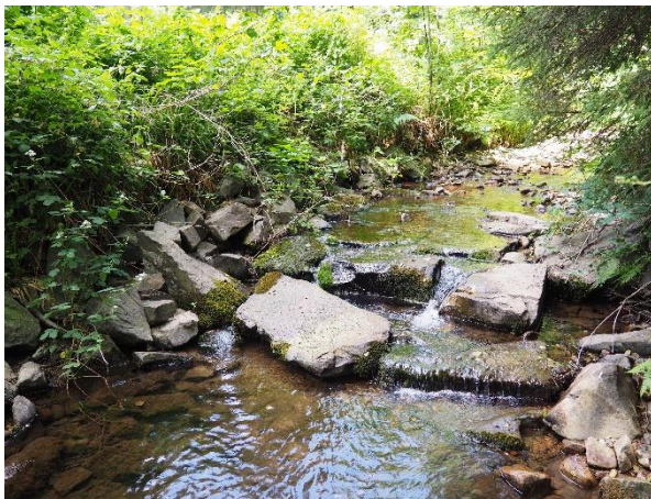
Abbildung 15: Objekt-Nr. 026 - Blocksteinrampe - Blickrichtung stromaufwärts
