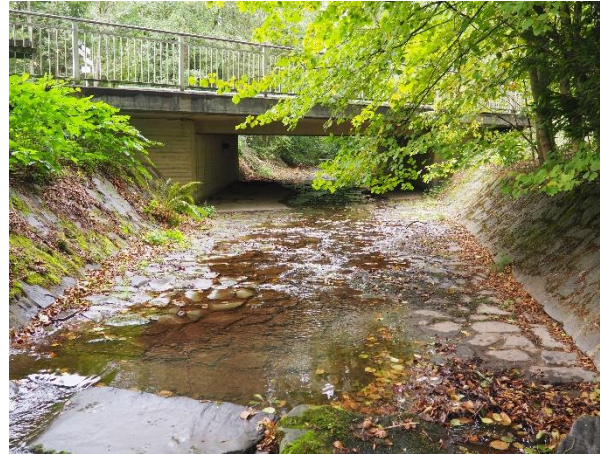
Abbildung 2: : Objekt-Nr. 007 – Brücke im Unterstrom -Blickrichtung stromaufwärts
