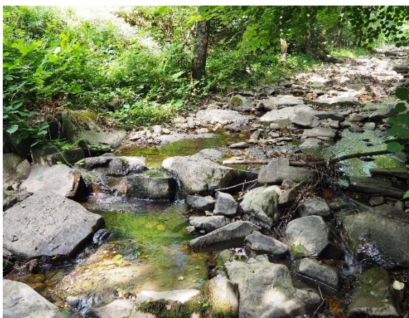
Abbildung 23: Objekt-Nr. 045 - Blocksteinrampe - Blickrichtung stromaufwärts
