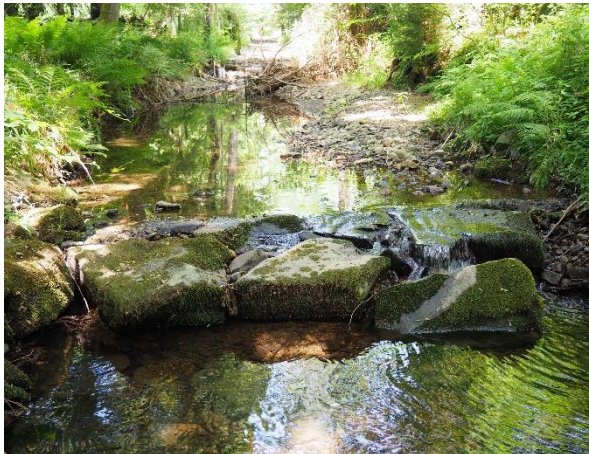
Abbildung 7: Objekt-Nr. 011 - Blocksteinrampe - Blickrichtung stromaufwärts
