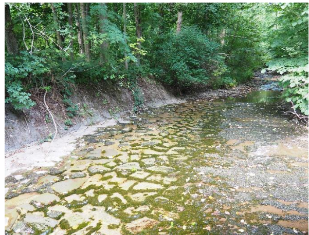
Abbildung 4: : Objekt-Nr. 007- Brücke im Oberstrom
