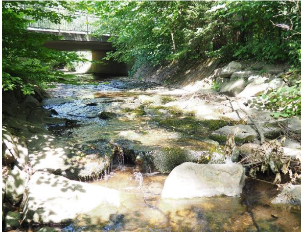
Abbildung 1: Objekt-Nr. 005 - Blocksteinrampe - Blickrichtung stromaufwärts
