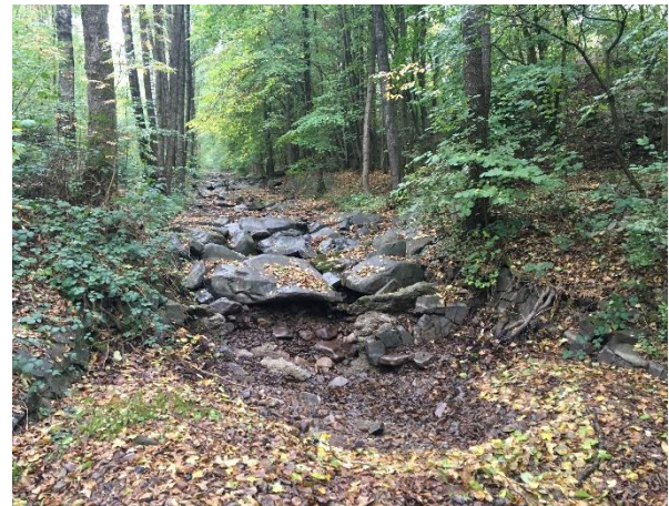
Abbildung 22: Objekt-Nr. 044 - Blocksteinrampe - Blickrichtung stromaufwärts
