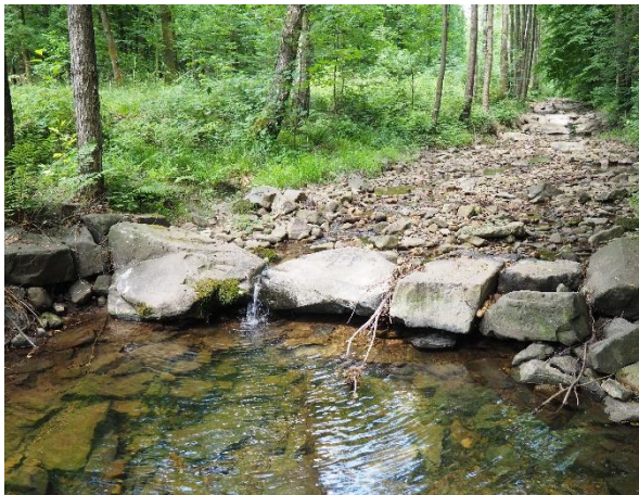
Abbildung 21: Objekt-Nr. 042 - Blocksteinrampe - Blickrichtung stromaufwärts
