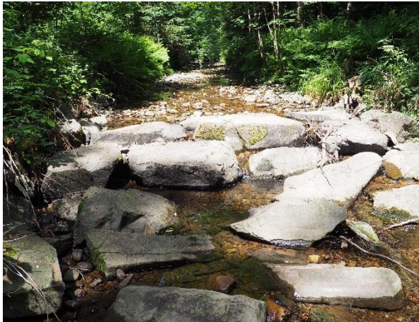
Abbildung 13: Objekt-Nr. 022 - Blocksteinrampe - Blickrichtung stromaufwärts
