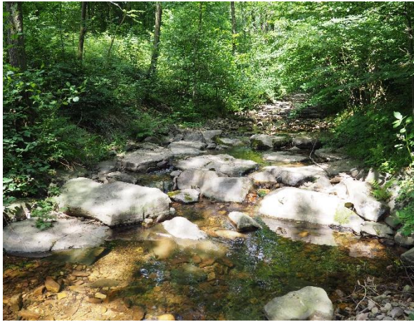
Abbildung 25: Objekt-Nr. 048 - Blocksteinrampe - Blickrichtung stromaufwärts
