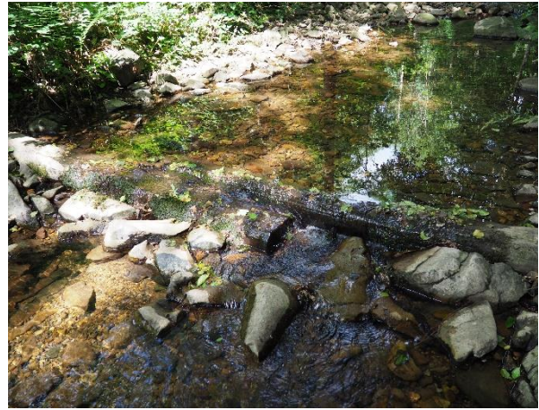
Abbildung 26: Objekt-Nr. 050 – Grundschwelle (Holz) - Blickrichtung stromaufwärts
