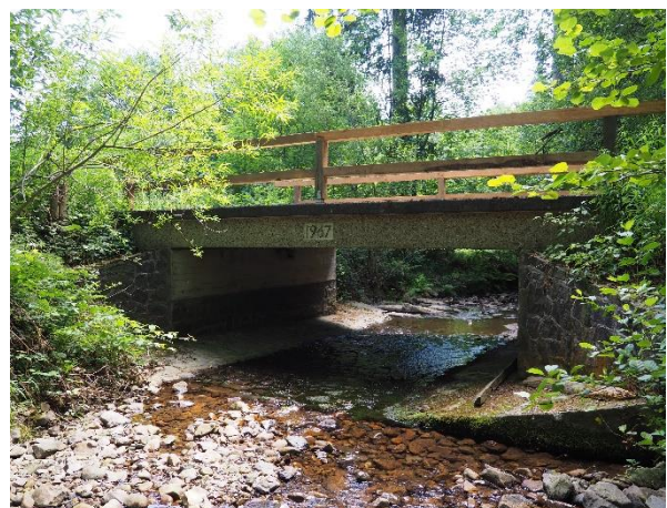
Abbildung 18: Objekt-Nr. 032 – Brücke - Blickrichtung stromabwärts
