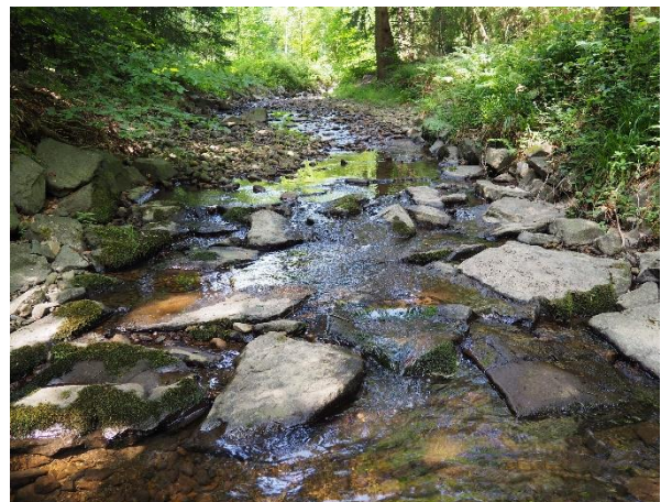
Abbildung 12: Objekt-Nr. 019 - Blocksteinrampe - Blickrichtung stromaufwärts
