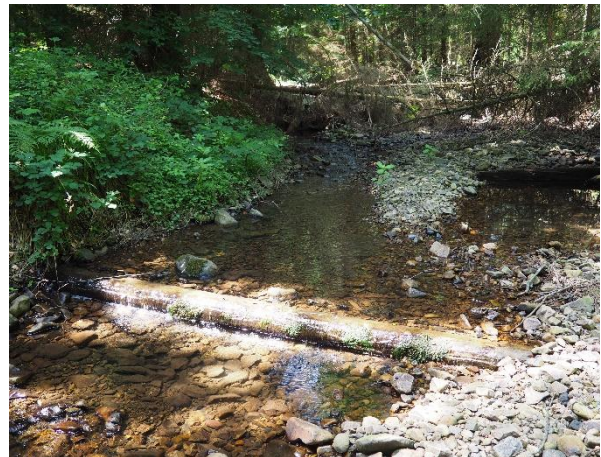
Abbildung 10: Objekt-Nr. 016 – Grundschwelle (Holz) - Blickrichtung stromaufwärts
