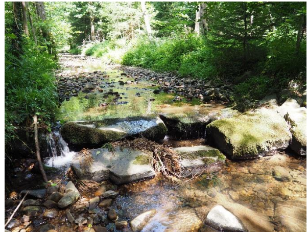
Abbildung 8: Objekt-Nr. 012 - Blocksteinrampe - Blickrichtung stromaufwärts
