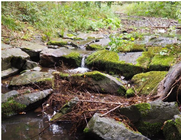
Abbildung 9: Objekt-Nr. 015 - Blocksteinrampe - Blickrichtung stromaufwärts
